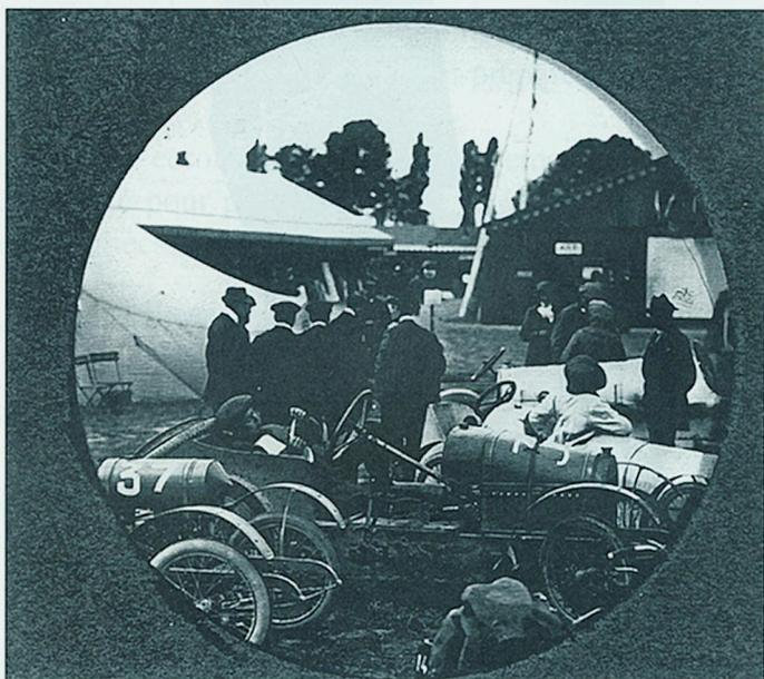
*Une vue des véhicules attendant les vérifications et le contrôle technique: au premier plan le N°37 un bi-cylindre SPFIM à refroidissement par air et derrière un autre SPHINX à refroidissement par eau; les SPHINX étaient construits sous licence à Courbevoie par F.FERRIER sous le nom de SPHINX-GLOBE, mais ils avaient été imaginés par J.H FOSTER de Londres.*
